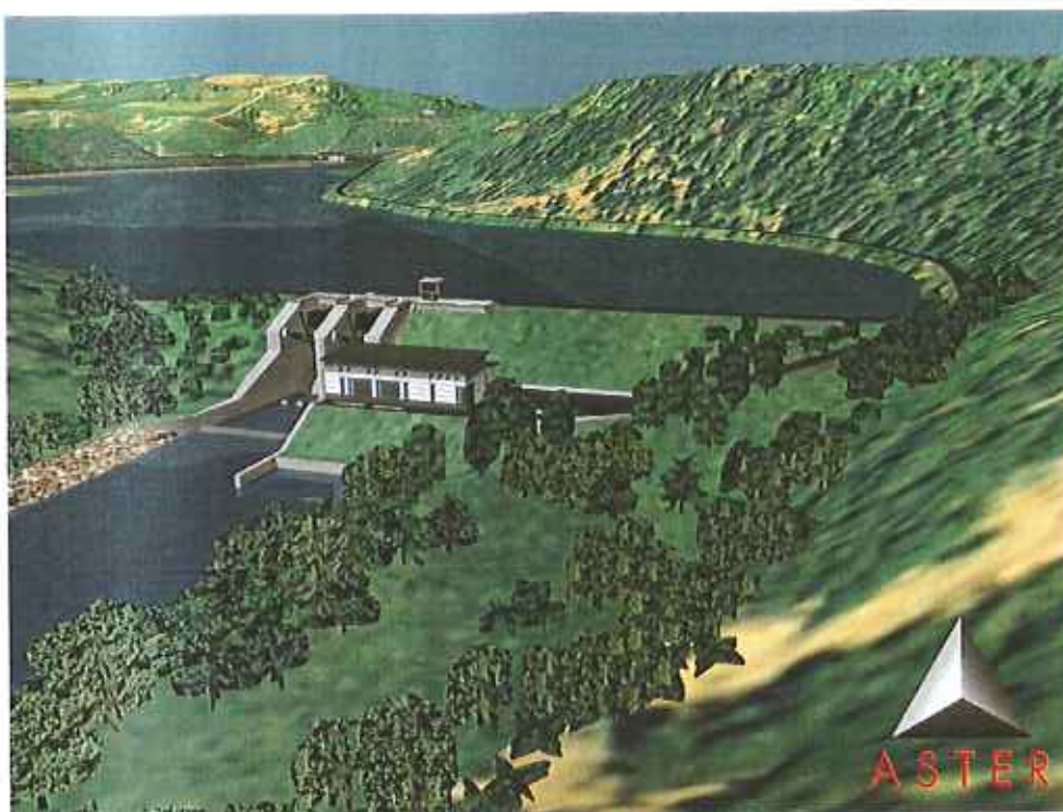
Slika 9: Pogled na pregrado izravnalnega bazena in HE Moste III
