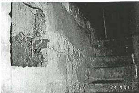
Slika 4 - Zunanja in obložna stena južnega stopnišča
