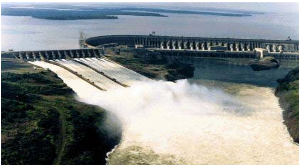
Sl. 5 - Brana Itaipu - (Brazil). Energetska instalisana snaga od 12500 kW
